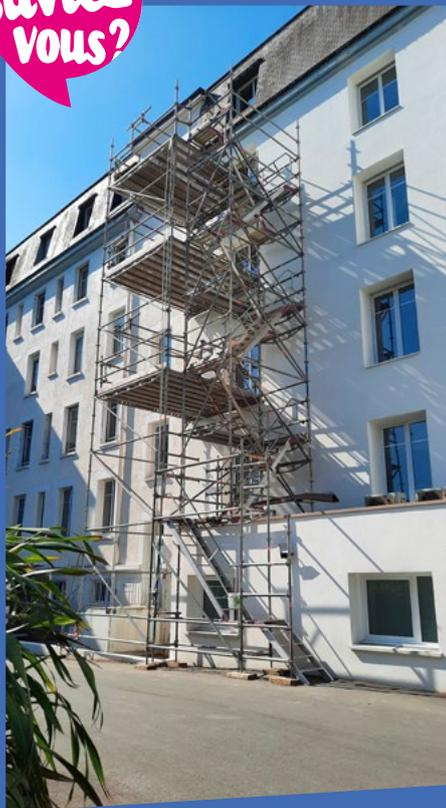
Pour cette phase du chantier, un échafaudage a été installé début février et désinstallé mi-juin, pour l'évacuation des gravats par l'extérieur, et ainsi éviter aux ouvriers du chantier de passer par les couloirs des services de soins.
